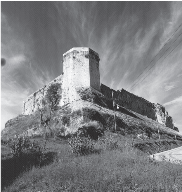
sotto una delle due torri ottagonali del castello svevo
